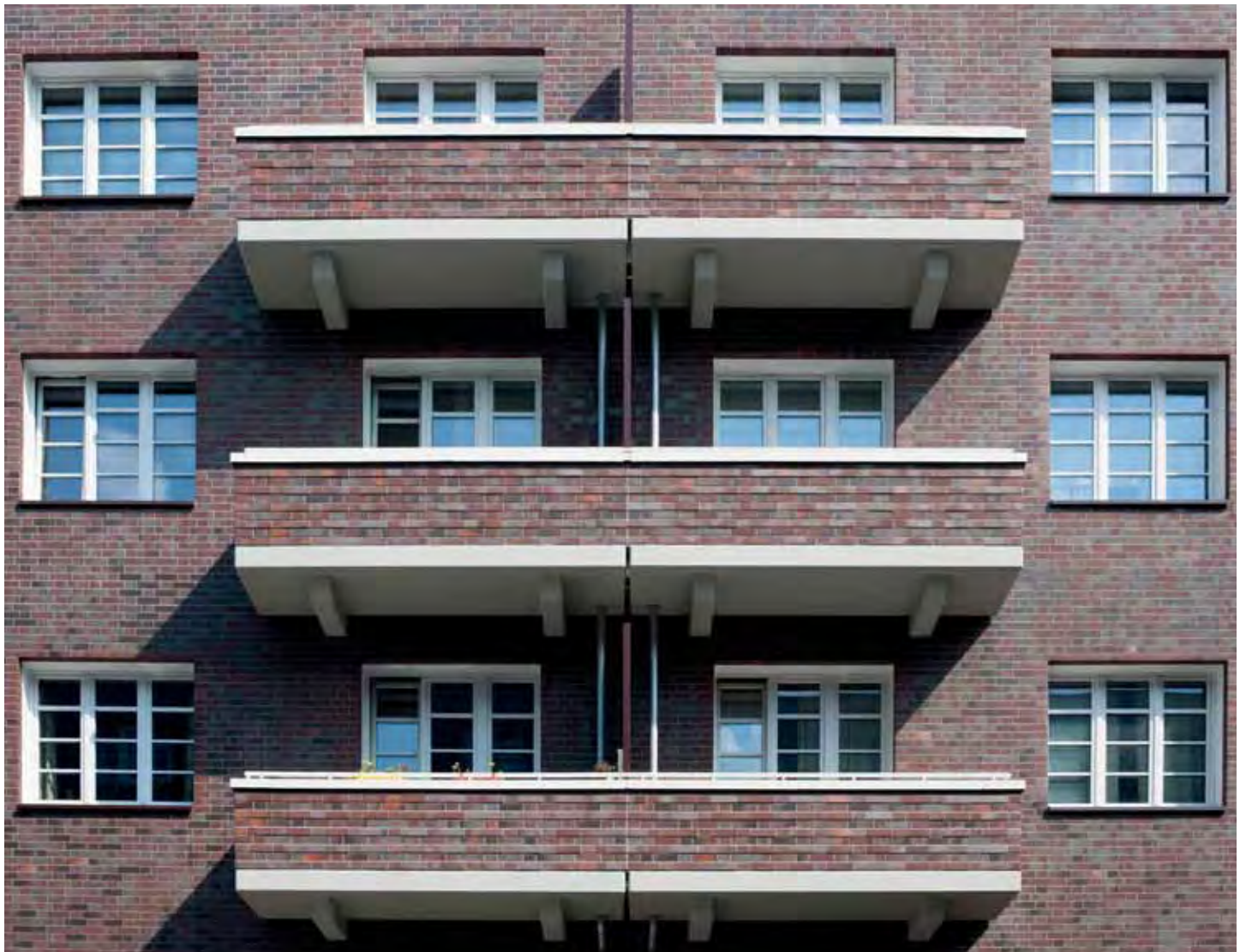
Gebäudeecken mit Winkelriemchen und Gesimse-Formsteine – Buchsbaumweg Hamburg
