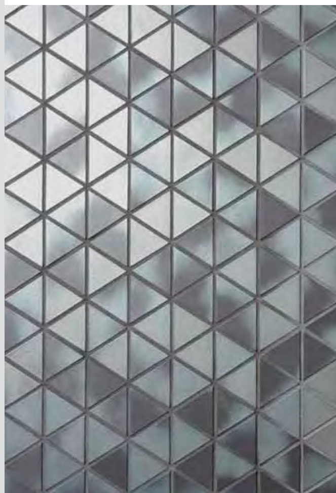
Dreieck-Keramiken mit metallischer Oberfläche, Fassade des Facharztzentrums in Bonn Beuel
