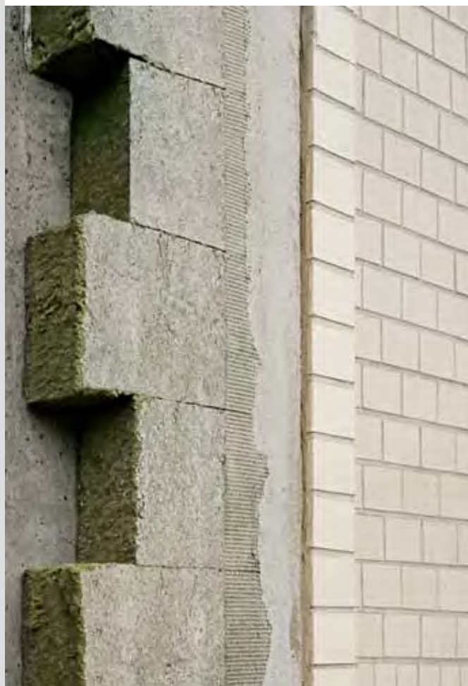
ABC-Quartiersteinverlegung auf WDVS-System
