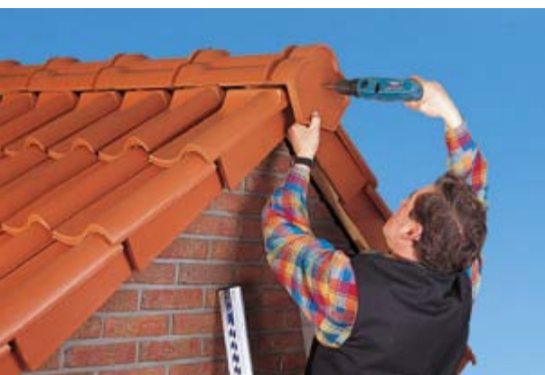
Лицевые стороны конька завершаются коньковой панелью (декоративной коньковой заслонкой).
