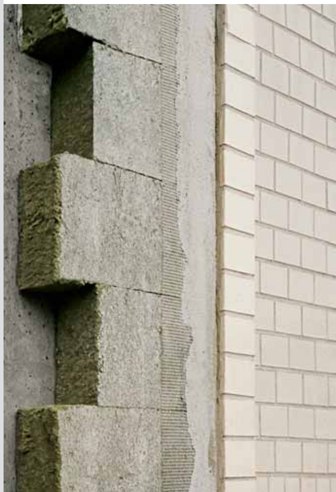
ABC-Quartiersteinverlegung auf WDV-System
