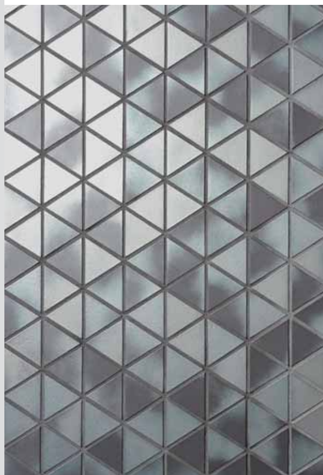
Dreieck-Keramik mit metallischer Oberfläche, Fassade des Facharztzentrums in Bonn Beuel
