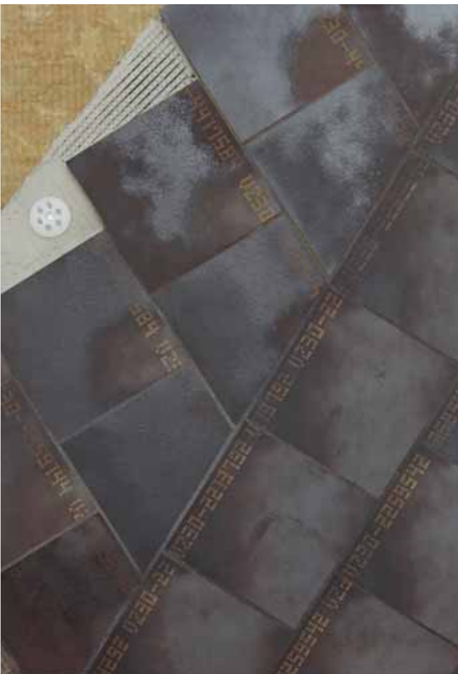
Shuttle Fassadenkeramik auf WDV-System
