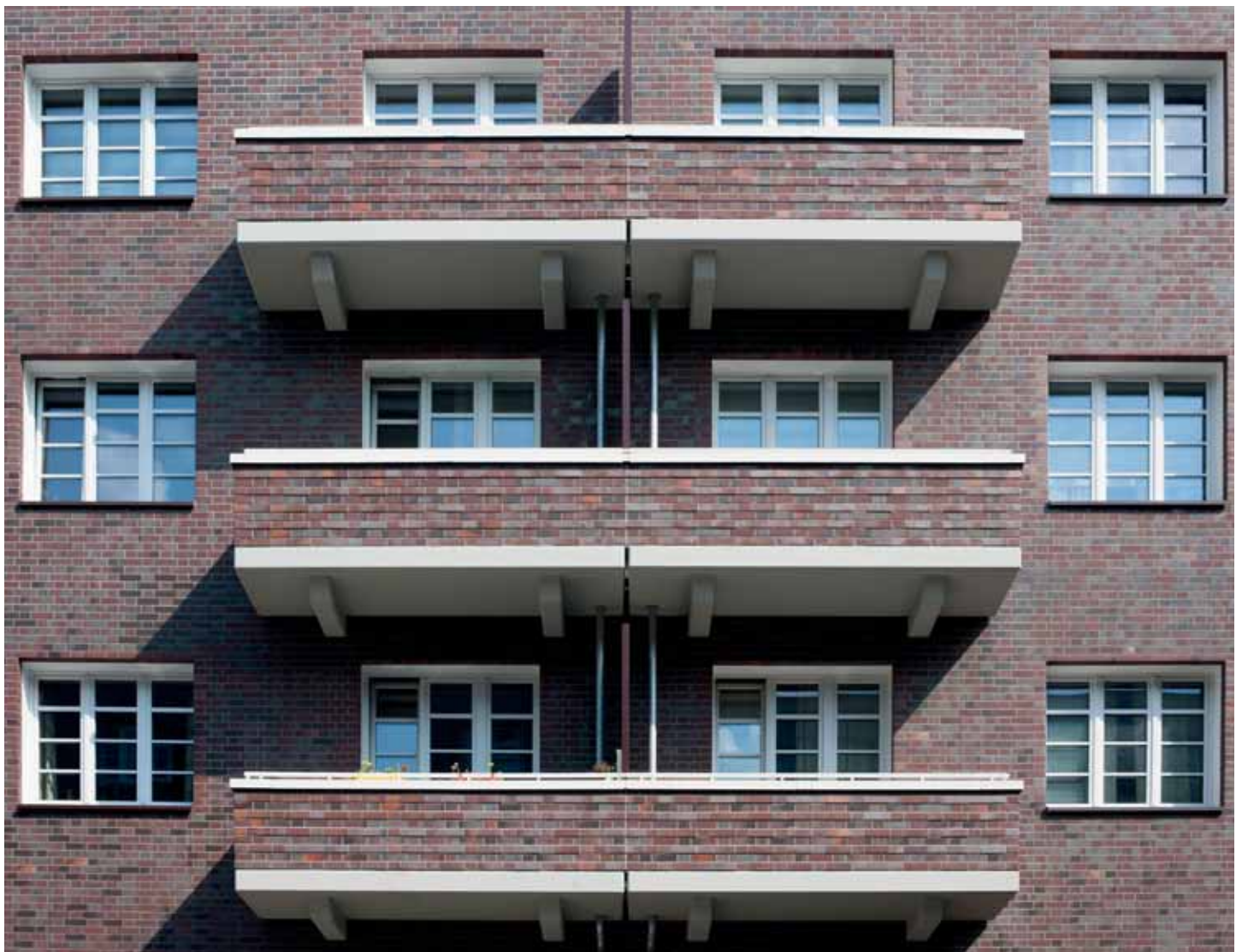
Gebäudeecken mit Winkelriemchen und Gesimse-Formsteine – Buchsbaumweg Hamburg
