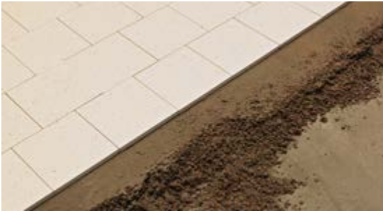
Beispiel für einen Bodenaufbau im Verbund.
